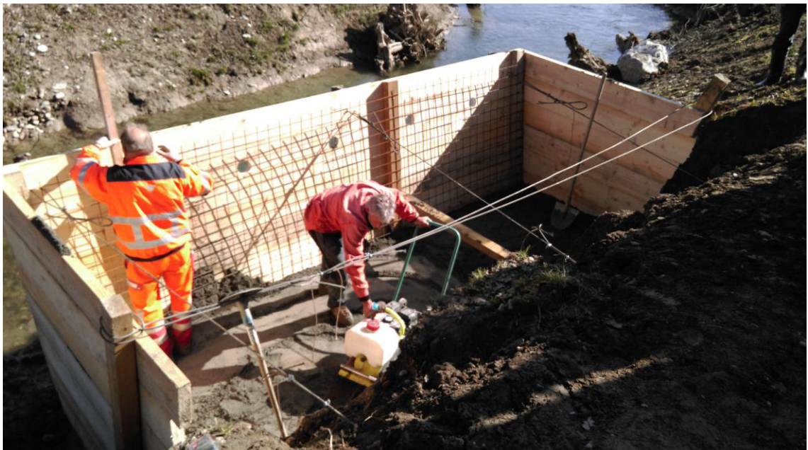
Foto während des Einbringens der Sandstabi (Foto Kästli Bau AG)
