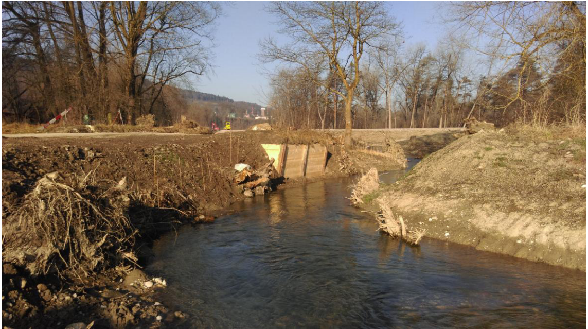
Foto der fertiggestellten Eisvogelwand. Blick in Fließrichtung abwärts (Foto Kästli Bau AG)
