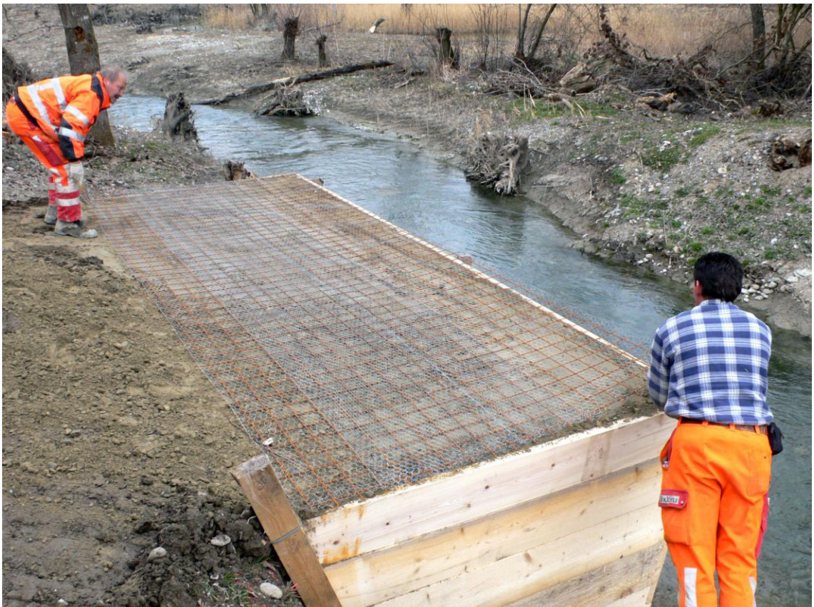
Foto des verlegten Armierungsnetzes mit aufgebundenem Zaungeflecht (Foto Andi Tromp)
