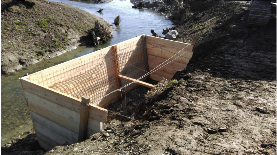
Foto des fertiggestellten und gesicherten Holzkastens (Foto Kästli Bau AG)
