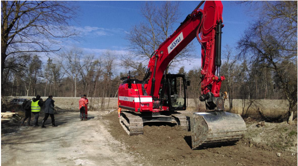
Foto des eingesetzten Baggers (Foto Kästli Bau AG)
