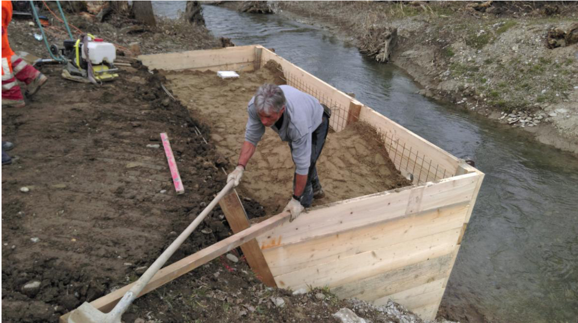
Foto während des Einbringens der Nistschicht (Foto Kästli Bau AG)
