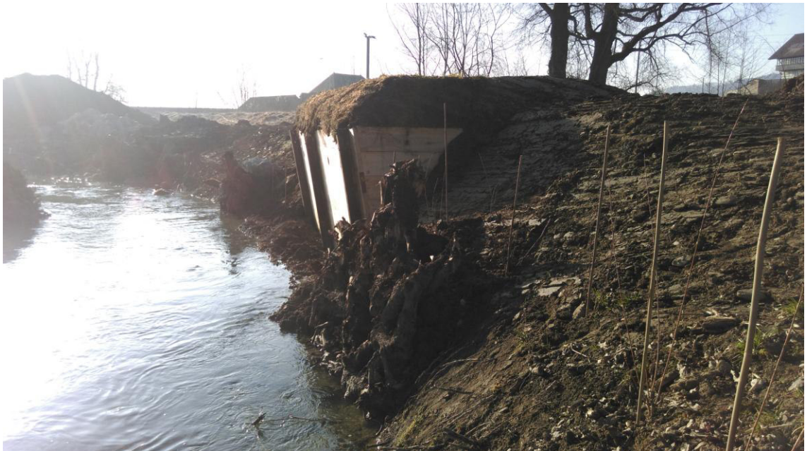
Foto der fertiggestellten Eisvogelwand. Blick in Fließrichtung aufwärts (Foto Kästli Bau AG)
