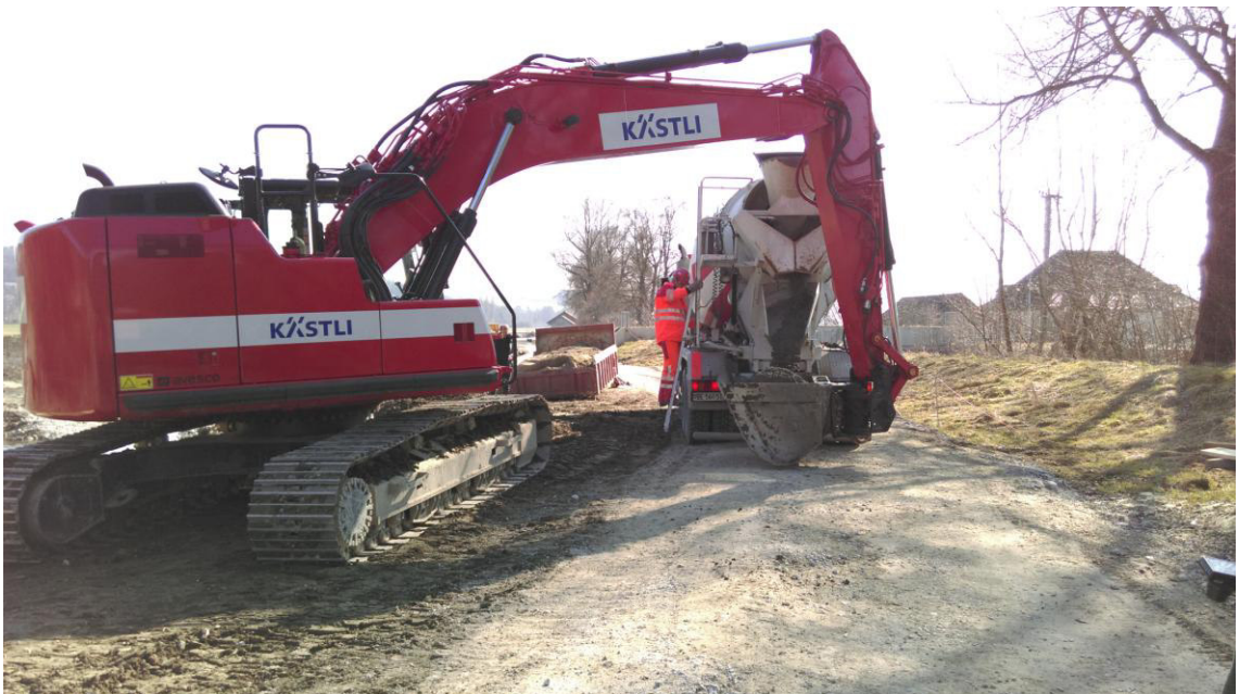
Foto der Sandstabi-Lieferung (Foto Kästli Bau AG)
