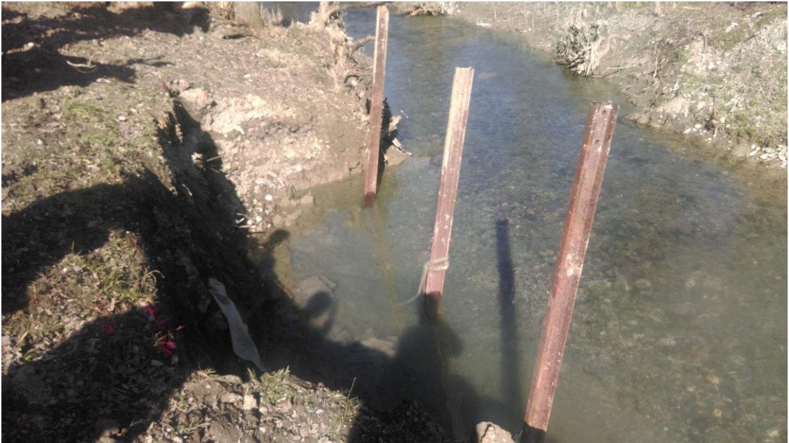
Foto der bereits versetzten Eisenbahnschienen (Foto Kästli Bau AG)
