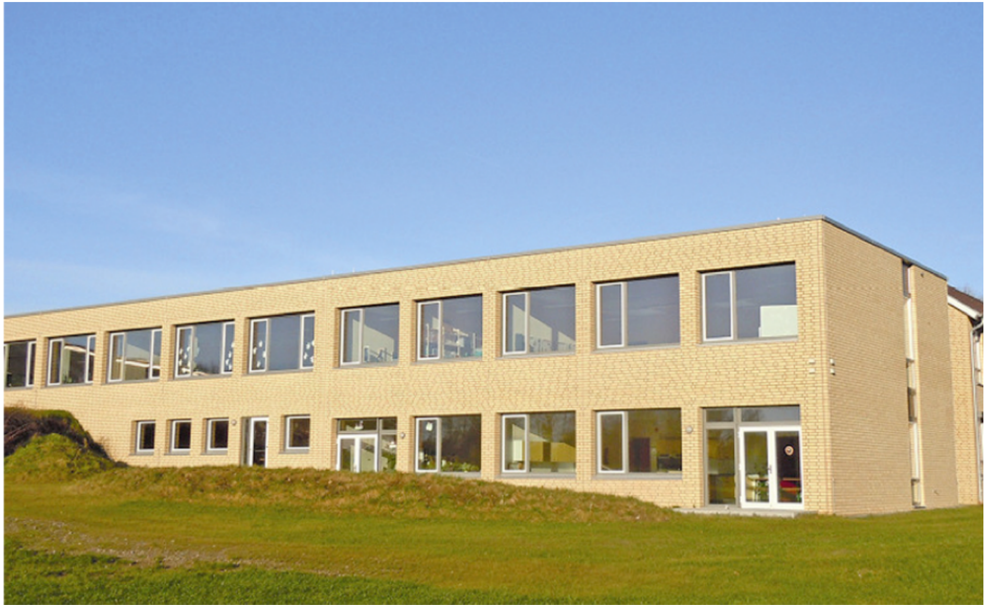
Vorbildliches Sanierungsobjekt: Die Grundschule Oeversee, Schleswig-Holstein, ist eine der zahlreichen Besichtigungsmöglichkeiten am Tag der Architektur. Die wärmetechnische, konstruktive Sanierung der Mauerwerksfassaden erfolgte über neues, kerngedämmtes Verblendmauerwerk – in Gestaltung und Material dem ursprünglichen Erscheinungsbild entsprechend. Architekt: Schüler Architekten BDA Schüler – Böller – Bahnemann, Rendsburg.
