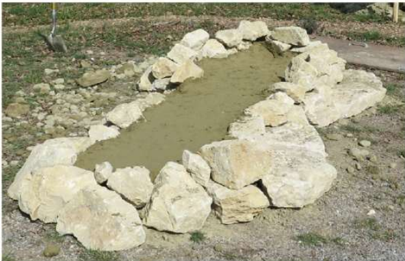
Rand für Erosionsschutz und Begrenzung.
