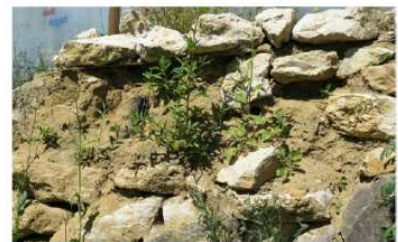
Sandwand mit Steinen befestigt. (Papiliorama)
