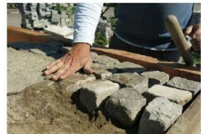
Wegplatten werden mit Sand befüllt.
