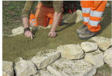
Schicht für Schicht wird festgestampft, Steine werden aussortiert.
