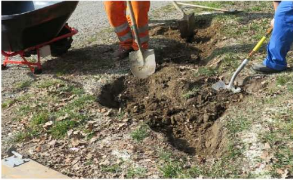
Grasnarbe entfernen, Mulde ausheben.
