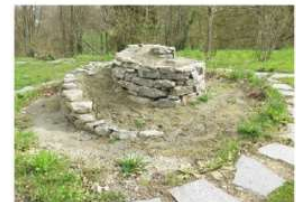
Sandgefüllte Spirale mit Trockenmauer.
