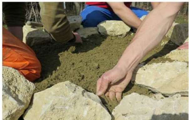
Gut hinterfüllen und festdrücken.
