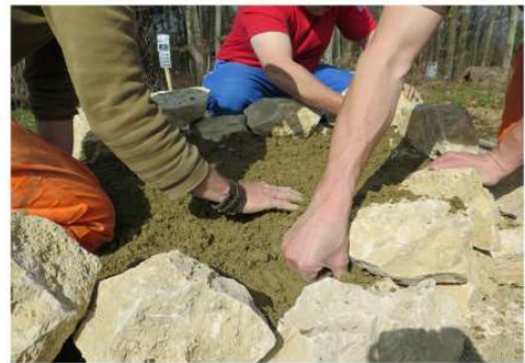
Sand wird kompakt in die Hinterfüllungen gedrückt.
