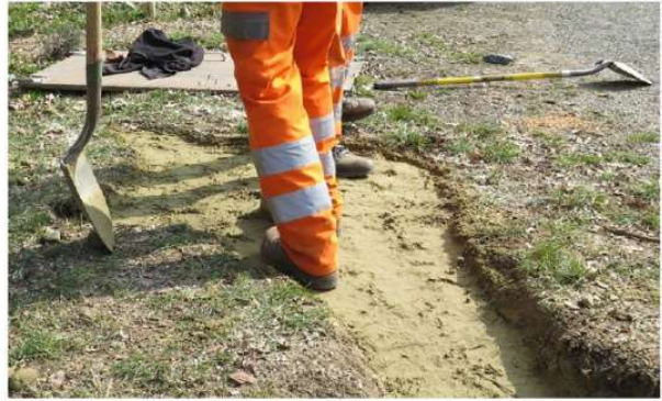
Kompakt mit Sand auffüllen.
