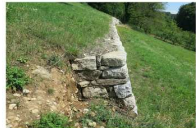
Abbruchkante vom Trockenmauerbau. (Vogelrüti AG)
