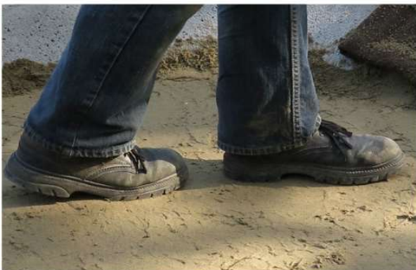
Schicht für Schicht gut feststampfen.
