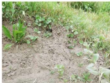
Abrutschkante, die freigehalten wird.
